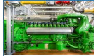
Inbetriebnahme der **neuen BHKW-Anlage** Kläranlage Seehausen führt zu einer Verbesserung des elektrischen Wirkungsgrades um über 30%.
