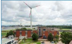
Ersatz von 4 alten Windturbinen auf der Kläranlage Seehausen durch eine **neue Windkraftanlage**: Erhöhung der Windstromproduktion um Faktor 10
